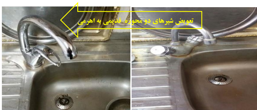
تصویر ۳ - تعویض شیرهای دو محوره (کلاسیک) و تبدیل به اهرمی
