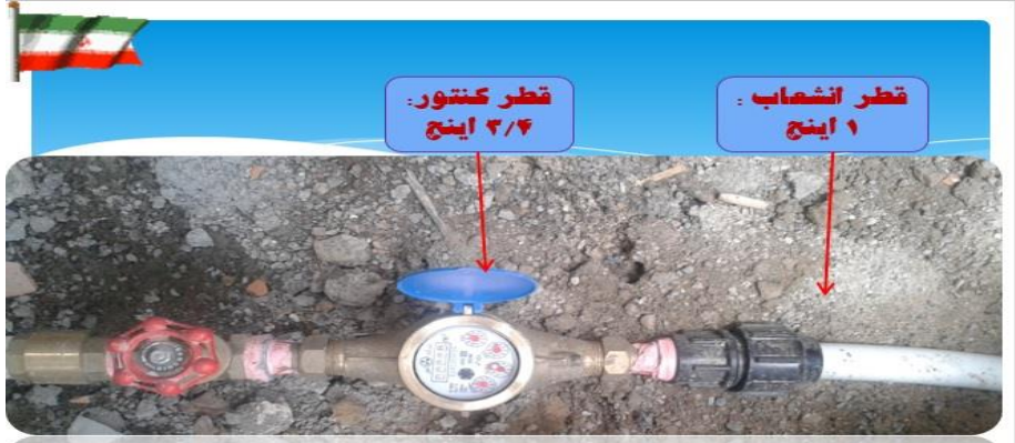
شکل ۱: تقلیل قطر کنتور به نسبت قطر انشعاب
