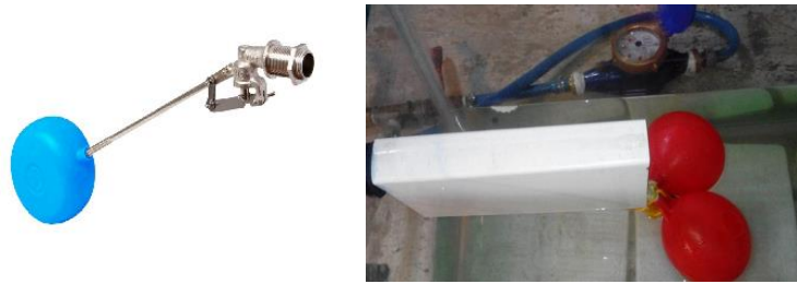
شکل ۳- فلوتر جدید پیشنهادی (شکل سمت راست) و فلوتر های رایج (شکل سمت چپ)
