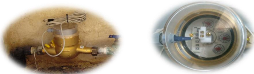
شکل ۱: نصب کنتور بجای کنتور مشترک
