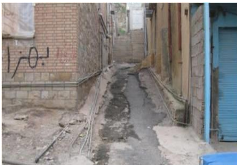
شکل ۲- شبکه توزیع فلزی و روکار منطقه
