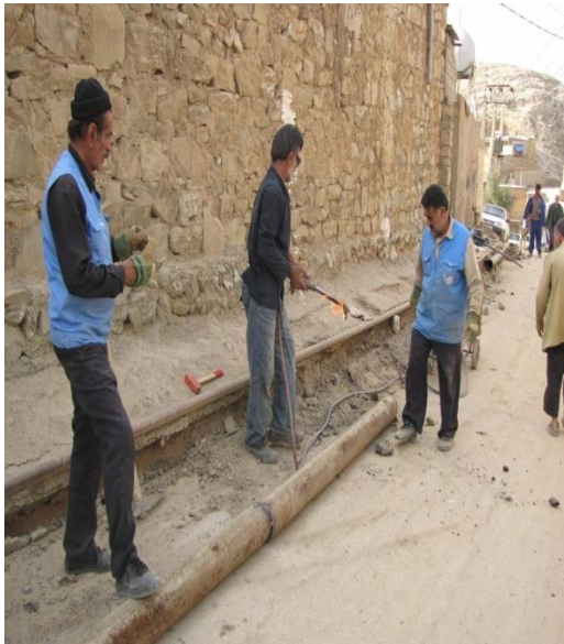
شکل ۴- جمع آوری خطوط فلزی روکار
