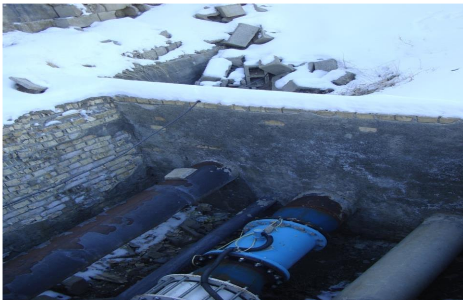
شکل ۲: ساخت منهول نامناسب فلومتر الکترومغناطیسی (منهول بدون دال می باشد)
